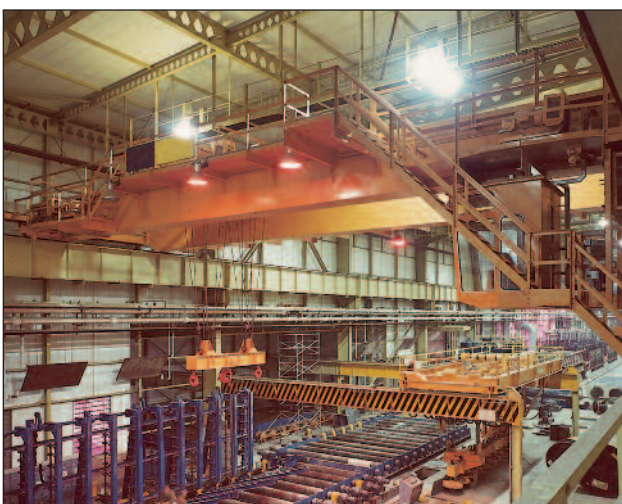
Stahlwerke. Kupplungen sitzen an 35 t Brückenkran und an Rollangantrieben.
