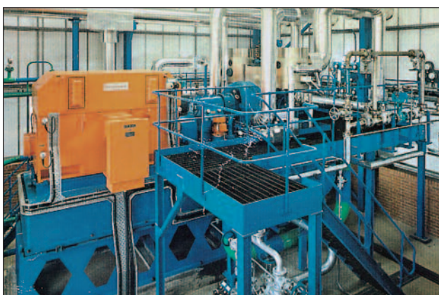
Dampfturbinen-Generatoranlage. Die Kupplung sitzt zwischen Getriebe und Generator.
