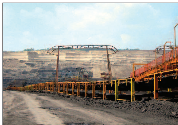
Förderanlage. Die Kupplungen befinden sich an Ein- und Ausgang der Förderanlagenantriebe.
